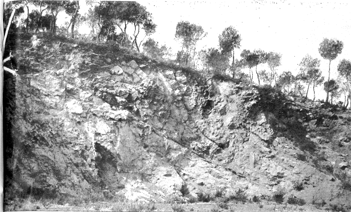
Fot. 1.—Roturas en la caliza cretácea del Km. 2 de la carretera del Pla del Manlleu.
